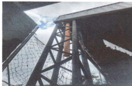
FOTO 12: Reparación de bajada de agua pluvial, tubo PVC 3"
