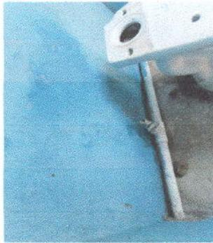
FOTO 3: Sustitución de tubería PVC lineal principal aguas negras
